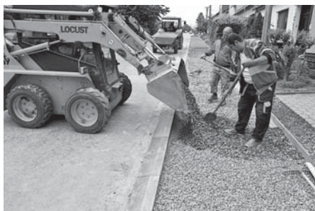
Oprava chodníku na ulici Zahradní – budování kufru.
