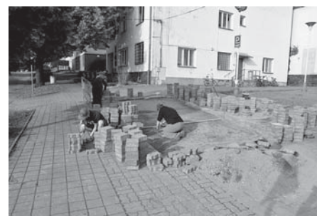
Oprava parkoviště u kina.
