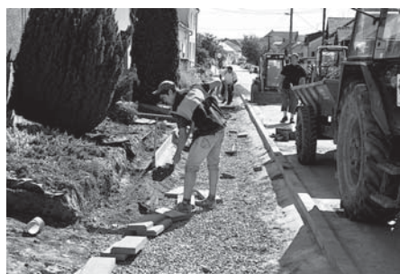
Rekonstrukce chodníku na ulici Ořechová.
